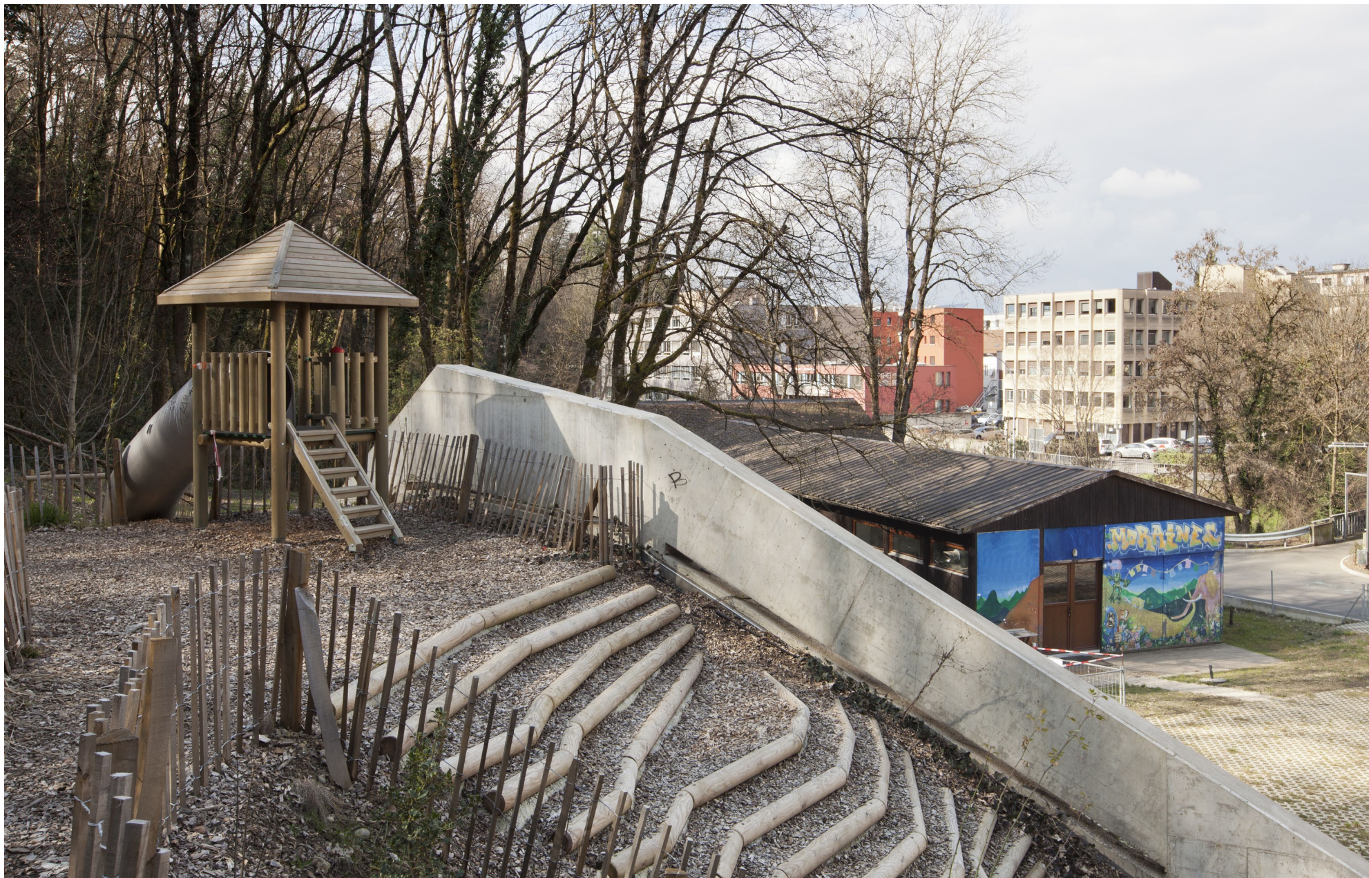
L'annexe des Moraines, en contre-bas, vue depuis le sommet de la sortie de secours du CEVA (aménagé en place de jeux pour les enfants).
